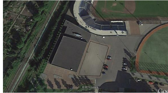
Dak Provincie Noord-Holland Hal
